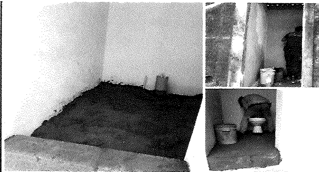
Foto 9: Sustitución de inodoros.
