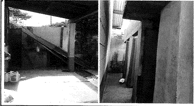
Foto1: Cambio de lámina de sanitarios y parte de la pila
