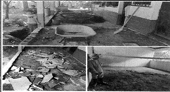
Foto 7: Sustitución de torta en corredor y un salón.
